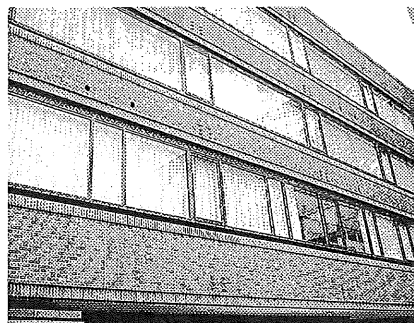
香中建が入居する香川県土木建設会館。この一角の小さな会議室で、150分に及ぶ積算見直し要望は練られた
