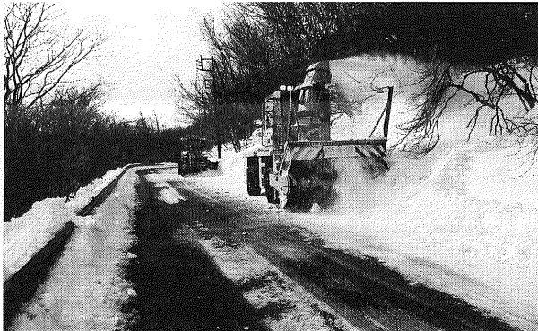
県道の除雪作業 (栃木県那須町)
