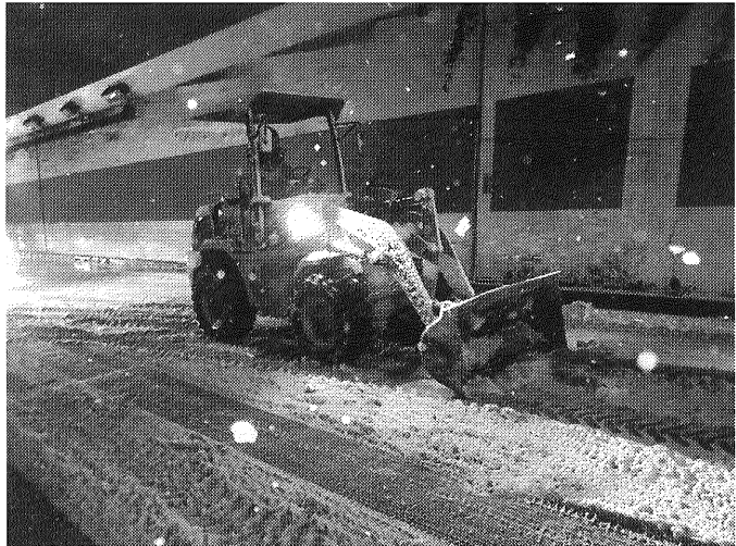
懸命に除雪作業を行う会員企業。長津田駅南口周辺
