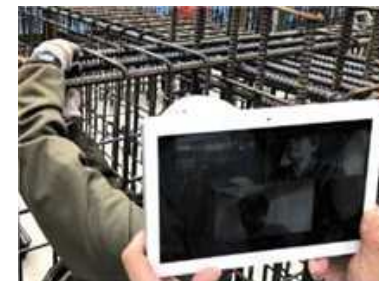
Webカメラを利用した遠隔検査
