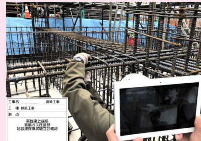
Webカメラを利用した遠隔検査
