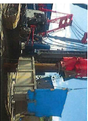
鋼管・既製コンクリート杭打工(中掘工)
