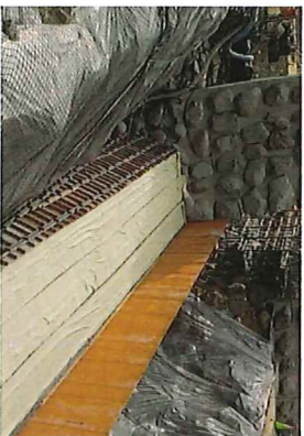
仮締切工 (砂防コンクリート締切)
