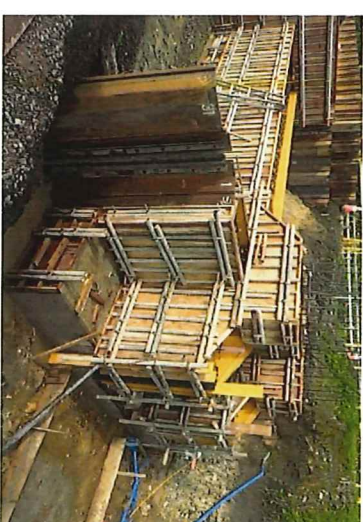
型枠工（省力化構造）
